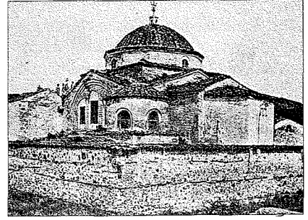
Koimesis Kilisesi'nin yıkılmadan önce çekilen bir fotoğrafı
